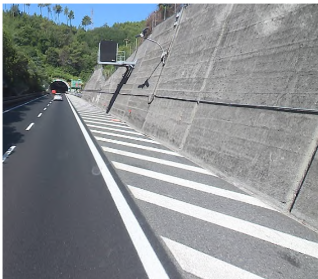
Figura 1 –Tipologia di muri di sostegno: "Controripa"
