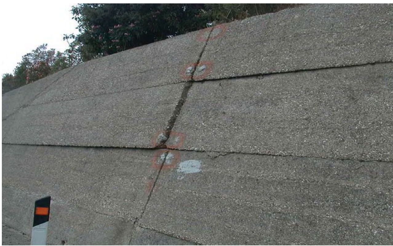
Figura 3 –Esempio di dislocazioni e rotazioni in corrispondenza dei giunti
