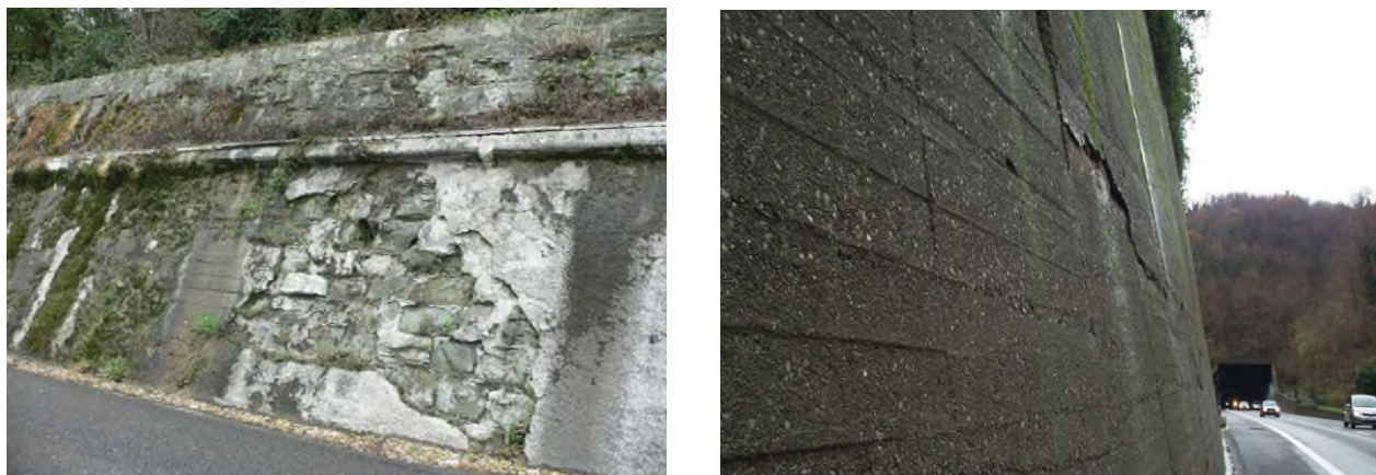
Figura 2 –Esempi di ammaloramento del paramento esterno del muro.
