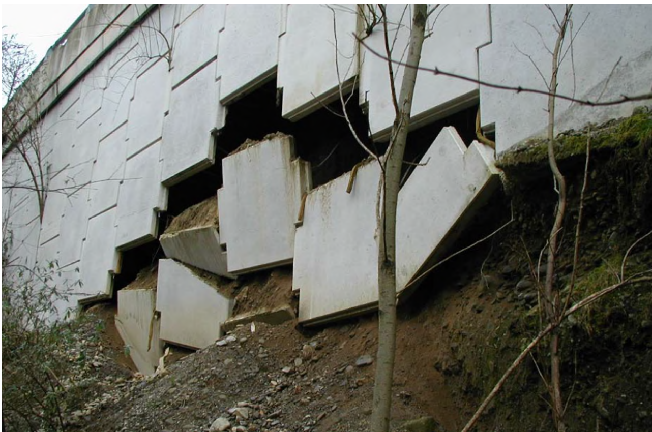
Figura 4 –Esempio di dissesto della struttura di un muro
